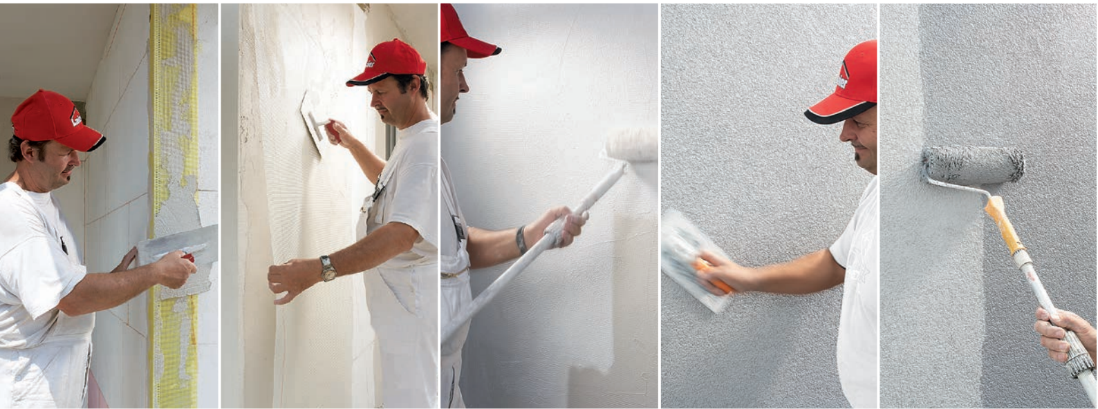
Zur Eckverstärkung an allen Gebäudeecken, PVC-Eckwinkel vollflächig anbringen.
